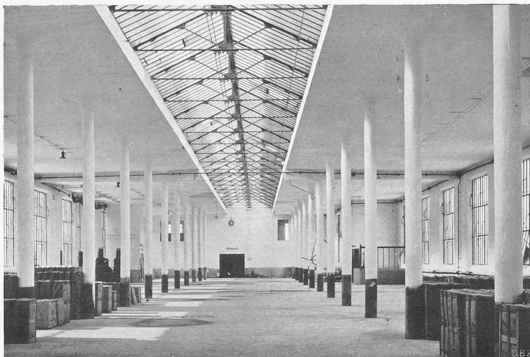
Runde Säulen, auskragende Platte zur Aufnahme des Oberlichts
