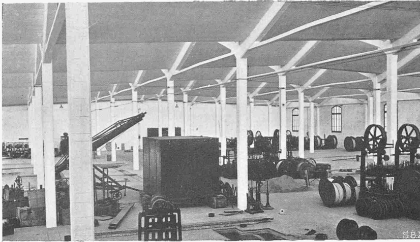
Kabelfabrik von Pirelli in Villa- nueva, Spanien
