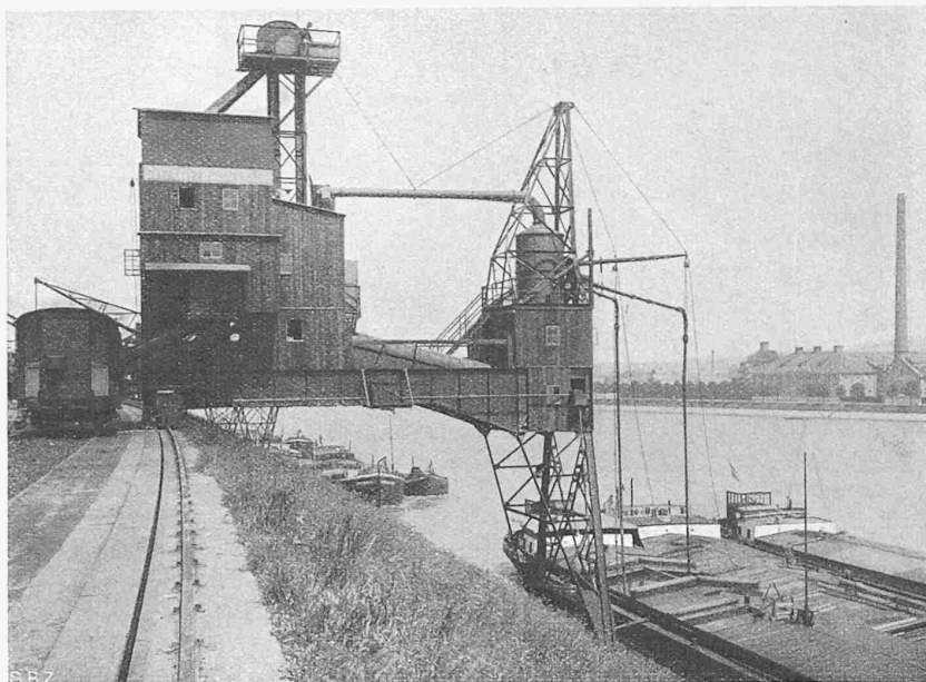
Abb. 27. Fahrbarer pneumatischer Getreideheber im Rheinhafen Basel - St. Johann.
