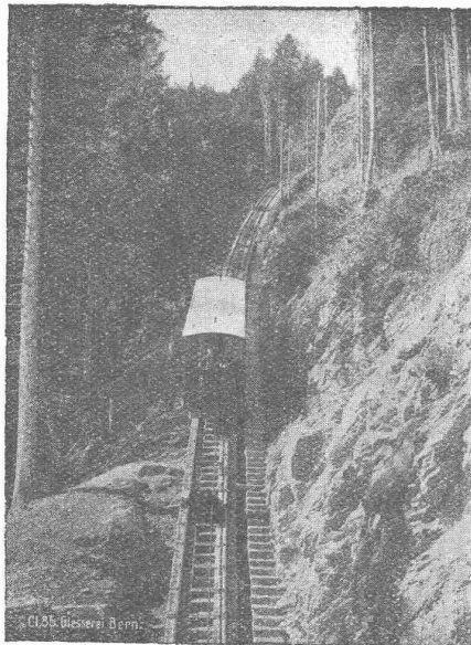
Seilbahn Niesen, I. Sektion, maximale Steigung 66%.
