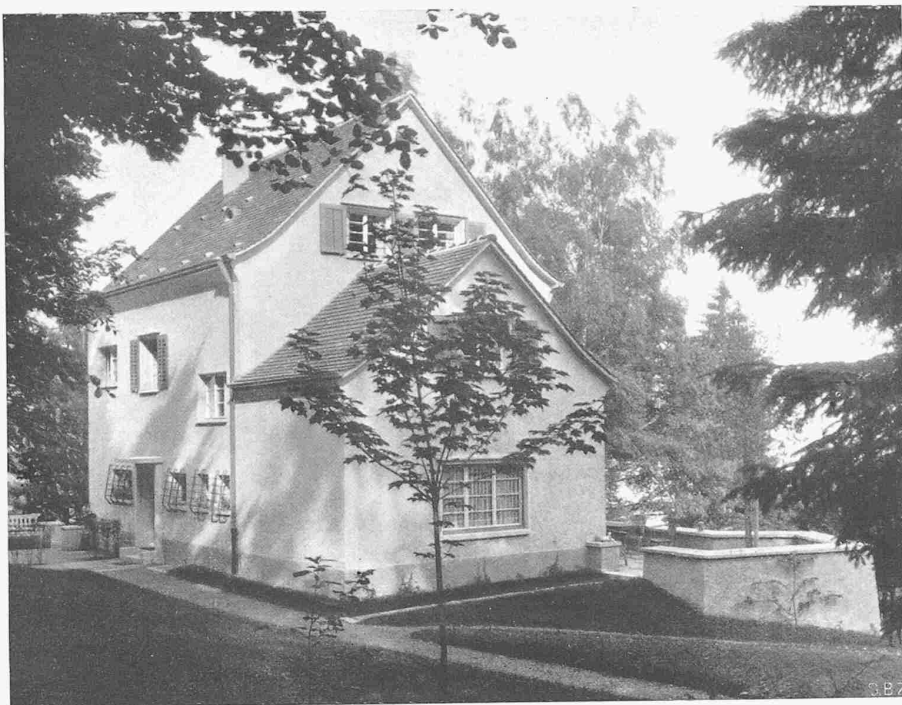
ANSICHT AUS NORDWEST
