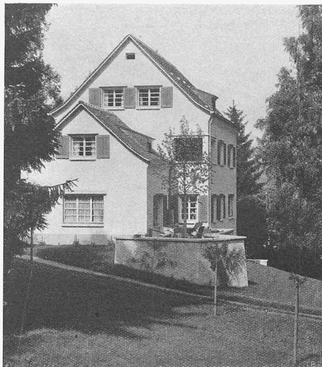
Abb. 2. Ansicht aus Südwest (Abendbeleuchtung).
