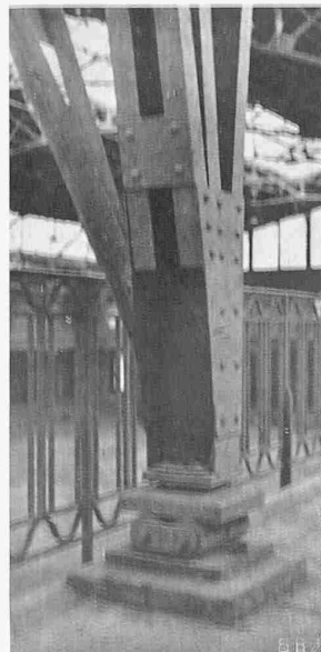
Abb. 13 u. 14. Festes und bewegliches Auflager der Dachbinder.
