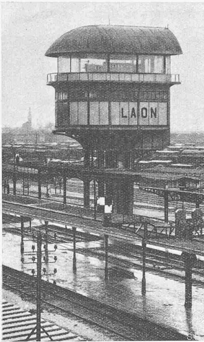
Abb. 1. Stellwerkposten im Bahnhof Laon.
