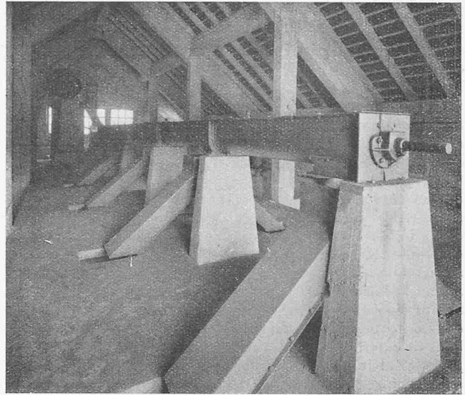
Abb. 3. Verteilungsschnecke im Dachboden. Im Hintergrud der Elevator.
