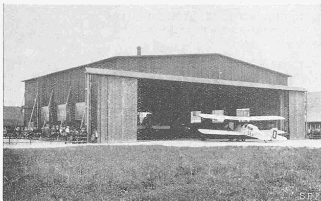
Abb. 2. Fertige Flugzeughalle von 28 m Breite.
