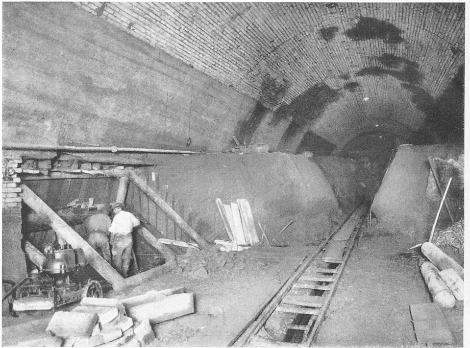
Abb. 11. Abbau der Strosse, Ausschachtung für Widerlager und Gewölbe-Unterfangung (UlMBERG).
