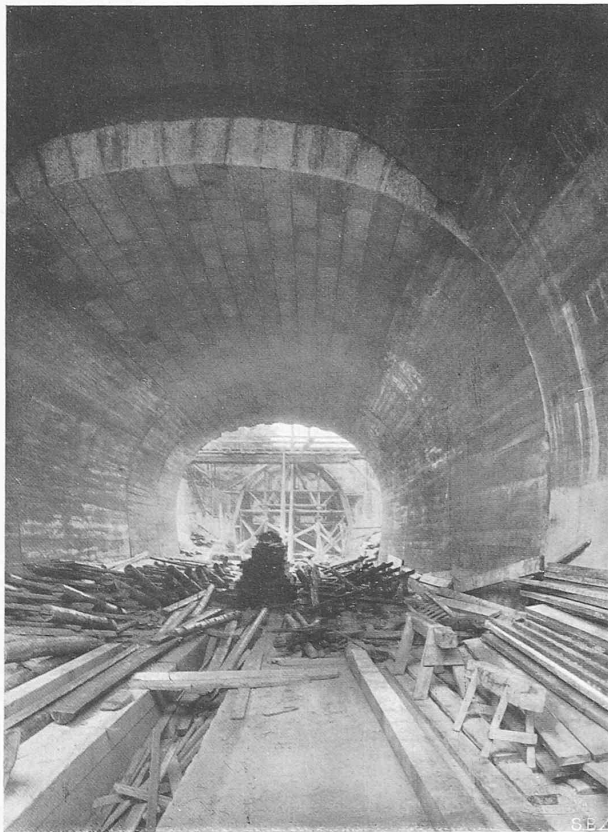
Abb. 6. Sihltunnel (rechtsufrige Hälfte), gegen Wiedikon gesehen. Granit-Gewölbestirne des reduzierten Unterfahrungs-Profiles.
