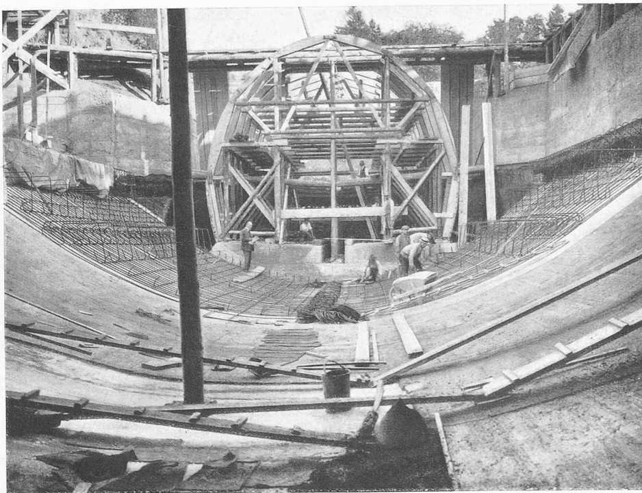
Abb. 7. Sohle des Sihltunnels (Armierung), gegen das Anschlussprofil des Ulmbergtunnels
