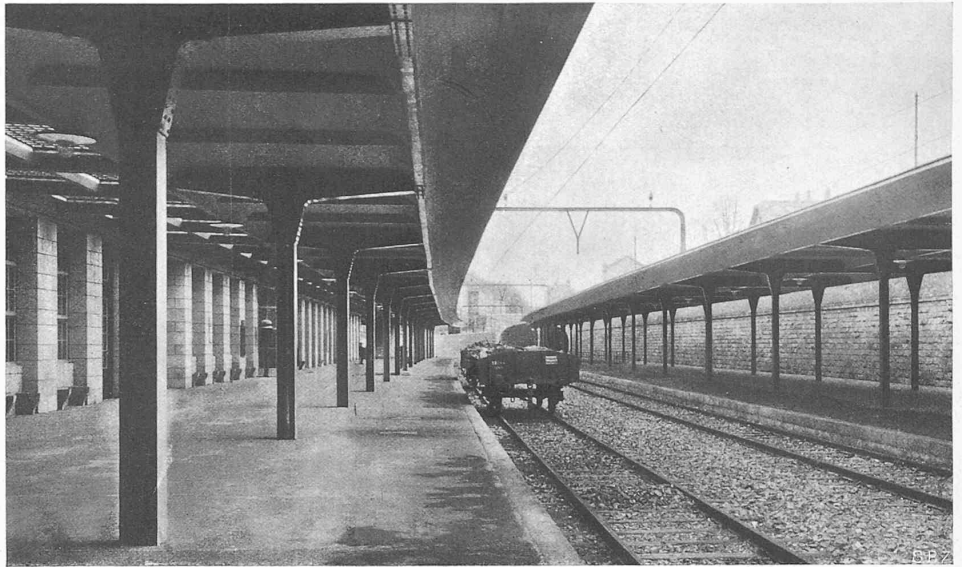
Abb. 23. Bahnsteigdächer des Bahnhofs Enge, gegen Süden gesehen.
