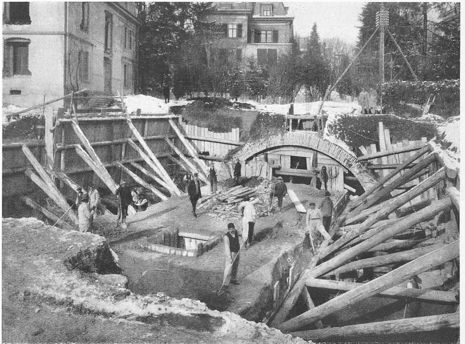
Abb. 9. Tagbau am Süden des UlMBERG-Tunnels (anschliessend am bergmännischen Teil, vergl. Abb. 8).
