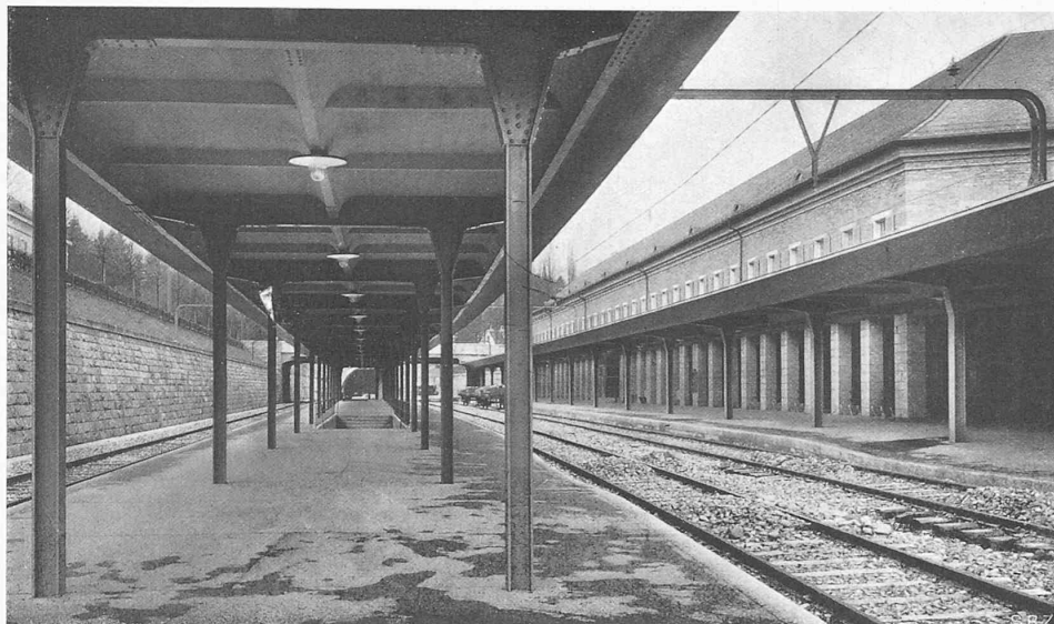
Abb. 24. Bahnsteigdächer des Bahnhofs Enge, gegen Norden gesehen.
