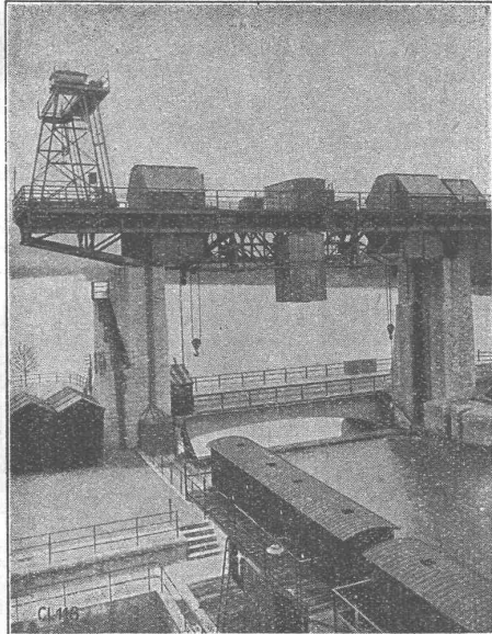
Fahrbarer Montagebockkran, Dammbalkentransportkran und Doppelwindwerke, Kraftwerk Augst-Wyhlen.
