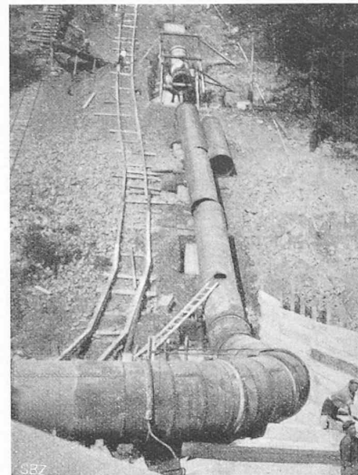
Abb. 27. Die Druckrohrleitung im Bau.
