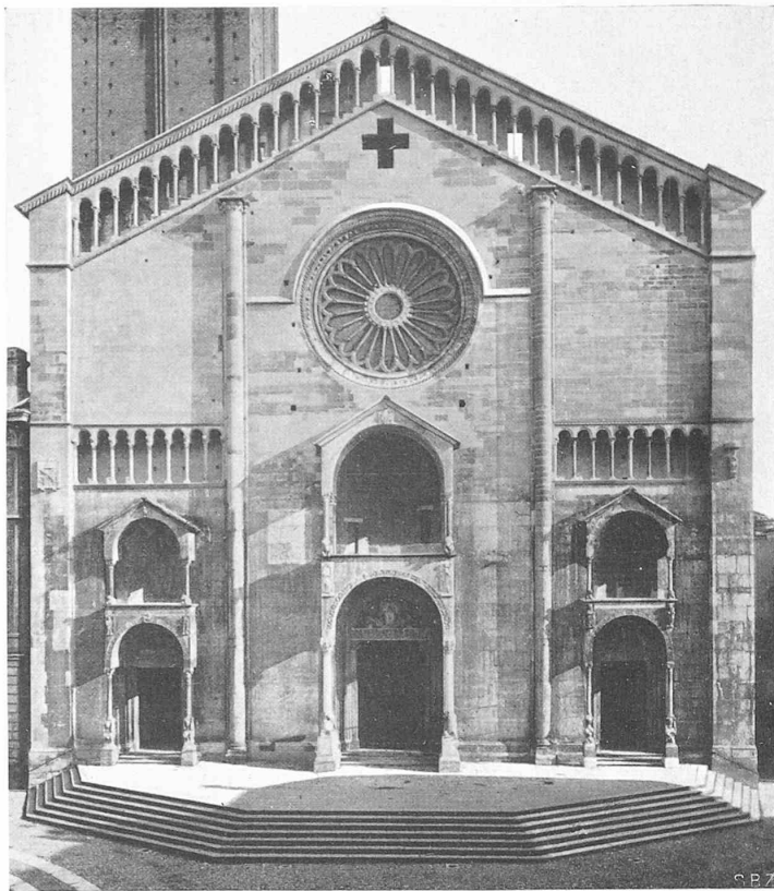
PIACENZA, DOMFASADE, BEGONNEN 1122 OBERE HÄLFTE VON DER ZWERG Gallerie AN MODERN ERNEUERT
