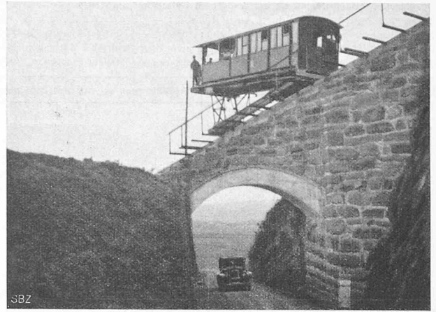
Abb. 4. Strassenüberführung bei Hm. 3,5.
