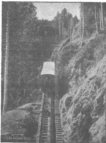
Seilbahn Niesen, I. Sektion, maximale Steigung 66 %.
