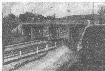
Römerstrassenbrücke in Winterthur
