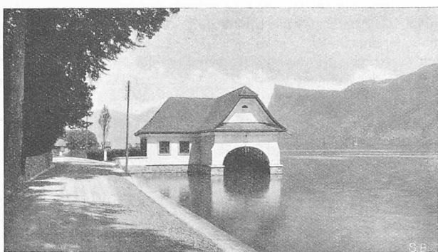
Abb. 6. Boothaus mit Blick gegen den Bürgenstock.
