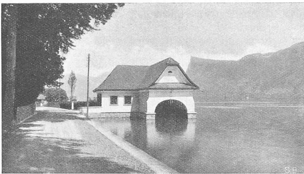
Abb. 6. Boothaus mit Blick gegen den Bürgenstock.
