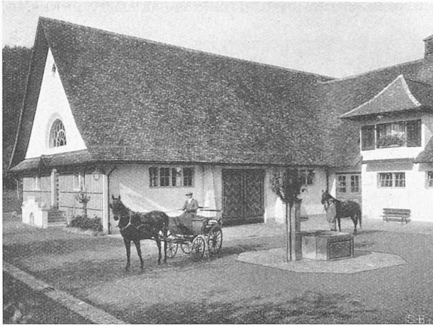
Abb. 1. Reithalle zum Landhaus Bocken. Hofansicht.
