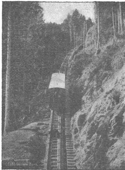
Seilbahn Niesen, I. Sektion, maximale Steigung 66 %.
