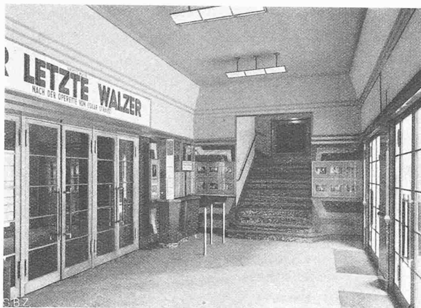
Abb. 13. Kassenhalle mit Eingang und Galerietreppe.
