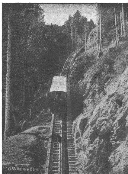
Seilbahn Niesen, I. Sektion, maximale Steigung 66 ‰.
