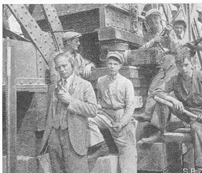
Abb. 9. Leitung der Arbeiten mittels Telefon.
