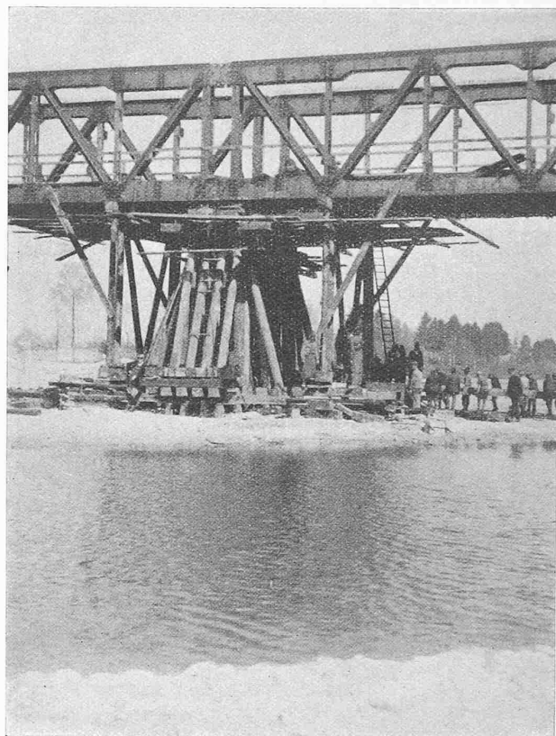
Abb. 12. Beidseitige Hebejoche für die Roth-Waagner-Brücken.
