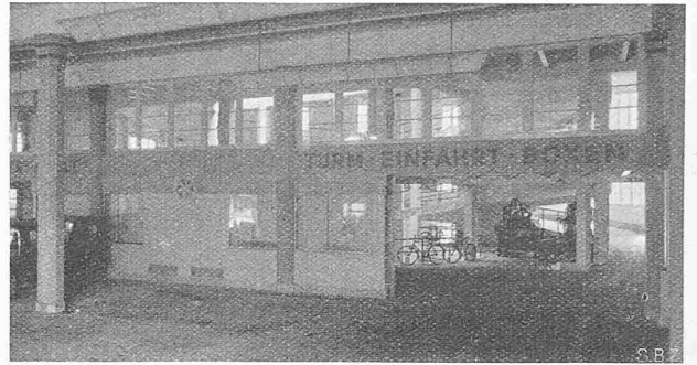
Abb. 20. Vorhalle vor der Turm-Einfahrt.
