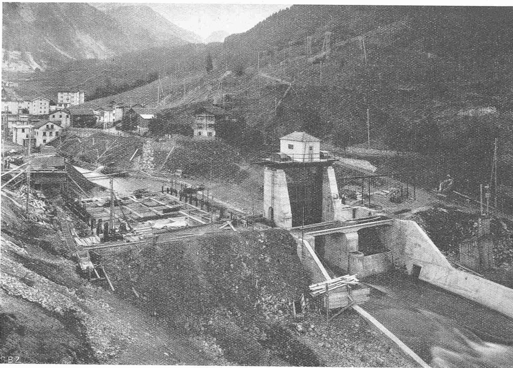
Abb. 11. Blick aus Norden auf Wehr und Kläranlage Klosters.
