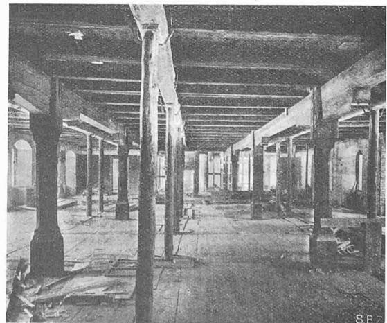
Abb. 6. Alter Holzständerbau im Obergeschoss.
