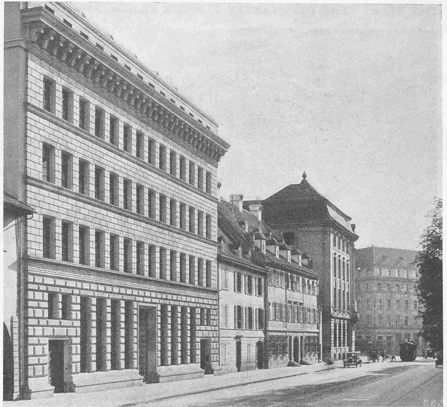
Abb. 1. Neubau der Schweiz. Nationalbank am St. Albangraben in Basel.
