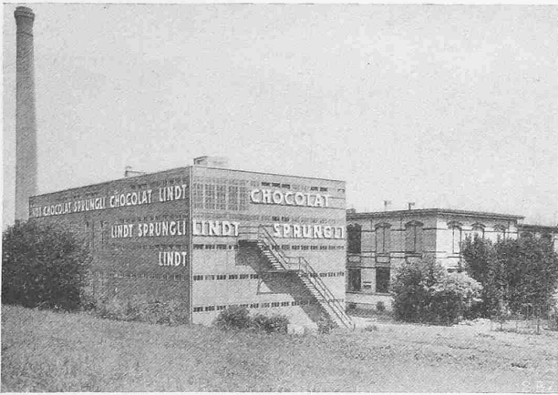
Abb. 1. Gesamtansicht aus Süden, rechts die Fabrik.
