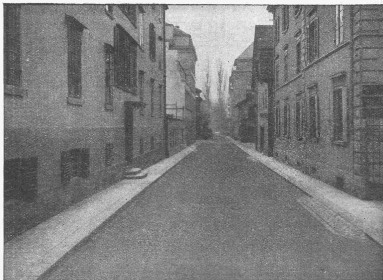
GLARNISCHSTRASSE ZÜRICH Walz-Asphalt: Topeka, 6 cm stark
