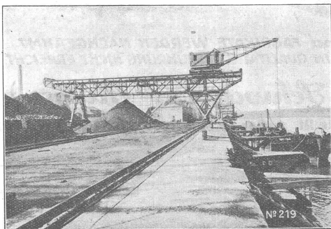
Verladeanlage im Hafen von Bilbao.
