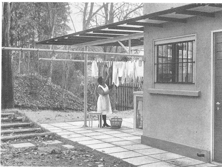
Abb. 5. Hintere Hausecke mit glasüberdecktem Vorplatz.
