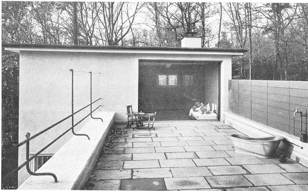
Abb. 12. Dachterrasse des Hauses Klusstrasse Nr. 50 in Zürich. — Arch. M. E. Haefeli, Zürich.
