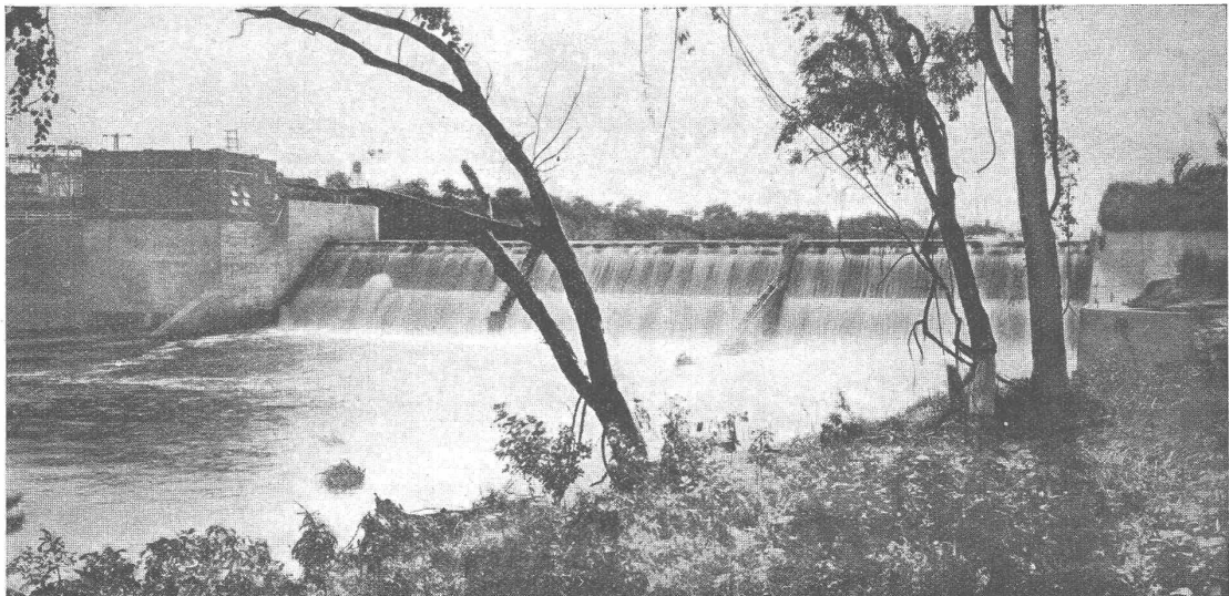
Dachwehr im Guadalupe River (Texas) mit drei Oeffnungen von je 26 m Breite und 3,65 m Höhe
