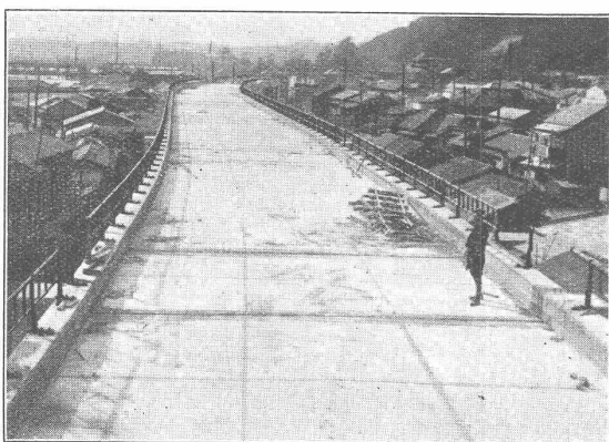
Yokohama. Viadukt der elektrischen Eisenbahn. 8000 m 2 mit Sika abgedichtet.
