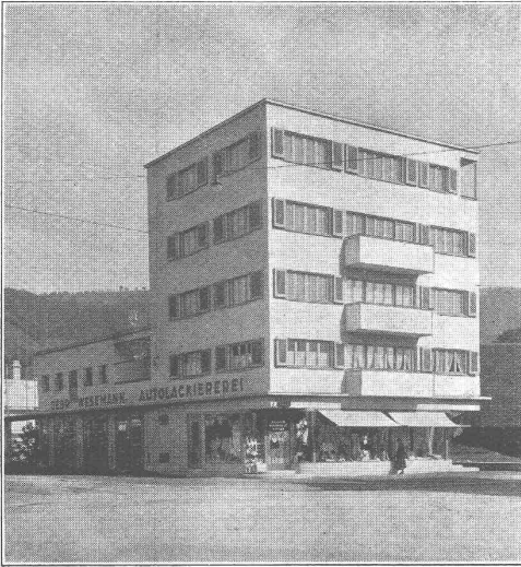
Neuzeitliches Wohn- und Geschäftshaus in Zug mit 3-lagigem Bitumitekt -Dach.
