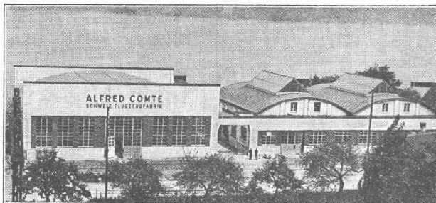
Flugzeugfabrik in Horgen 1700 m 2 Bitumitekt-Bedachungen grünschiefer-besandet
