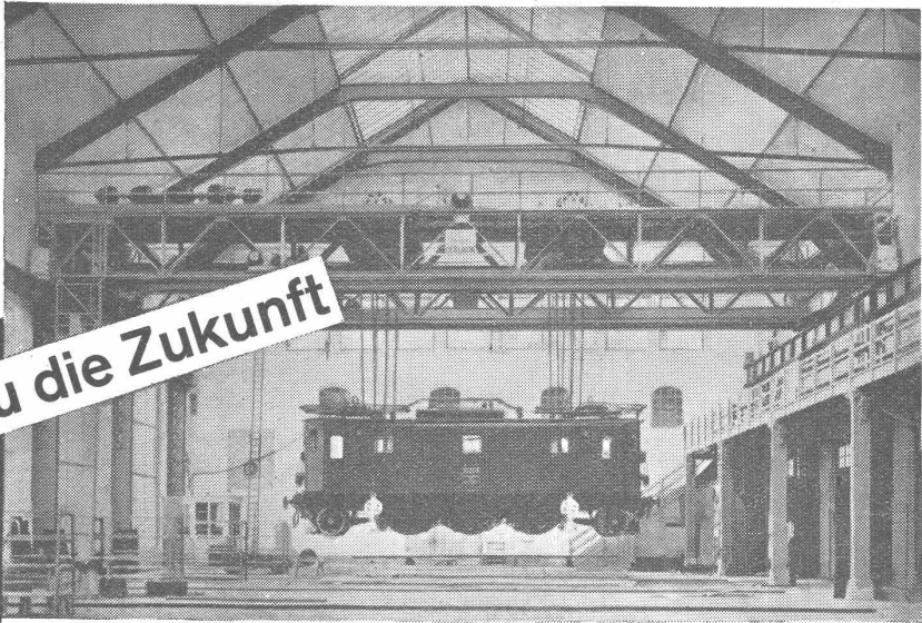
Montagehalle für elektrische Lokomotiven in Zürich der Schweizerischen Bundesbahnen
