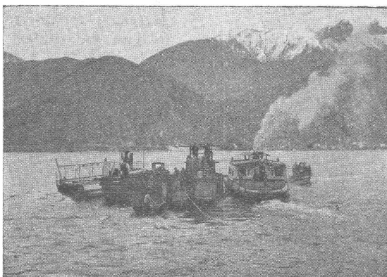
Abfahrt der Verlegeflotte in Poiana
