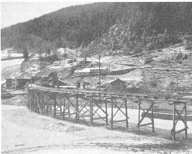
Abb. 3. Dienstbrücke zum Portal des Kehrtunnels.
