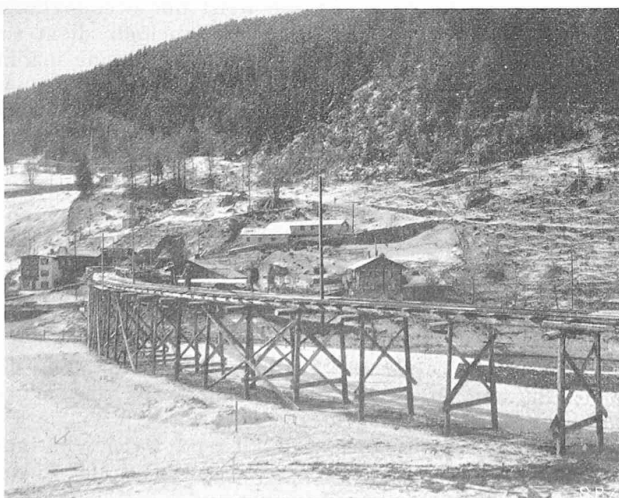
Abb. 3. Dienstbrücke zum Portal des Kehrtunnels.
