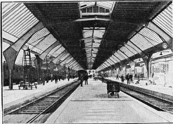
Umbau Hauptbahnhof Zürich; Perron-Längshalle I. Total 7 Hallen, nach unseren Berechnungen und Konstruktionsplänen ausgeführt.
