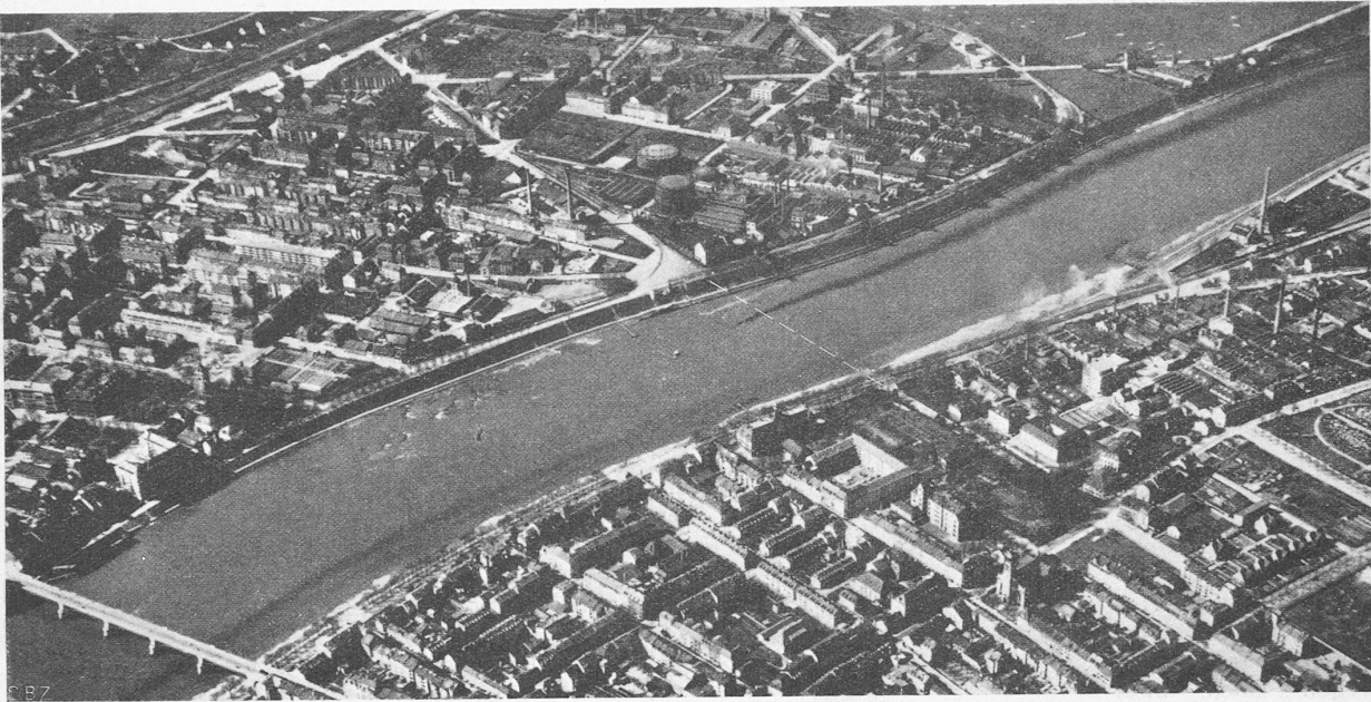
Fliegerbild aus Südost auf die Baustelle (weiss gestrichelte Linie) der Dreirosenbrücke (links die Johanniterbrücke).
