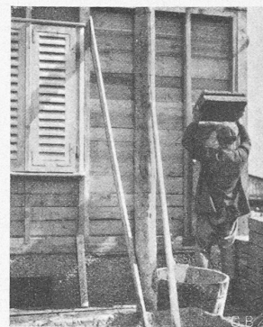
Abb. 2. Versetzen der Platten.
