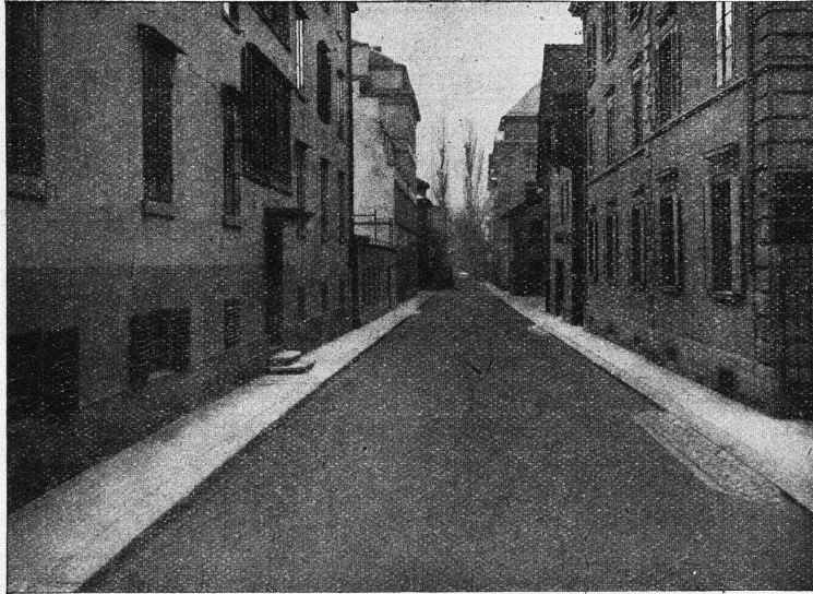
GLARNISCHSTRASSE ZÜRICH Walz-Asphalt: Topeka, 6 cm stark
