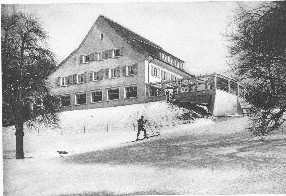
BERGHAUS BALDERN, AUF DER ALBISKETTE BEI ZÜRICH OTTO HONEGGER, DIPL. ARCH. S. A. D. G., ZÜRICH
