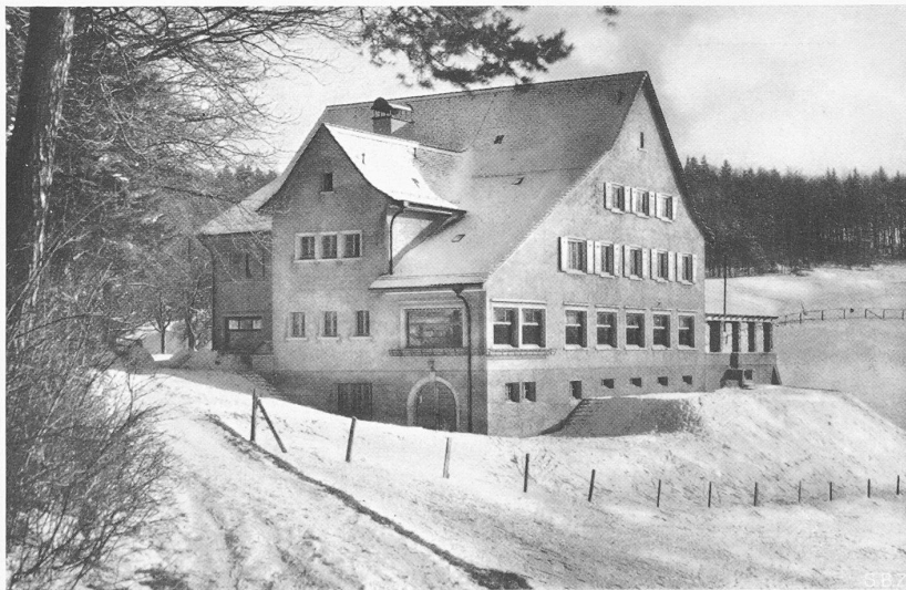
OBEN AUS SÜDWEST, UNTEN AUS NORDWEST
