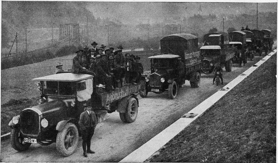
Sieben BERNA Kipper der aus zwölf BERNA bestehenden Kolonne für Abbrucharbeiten.
