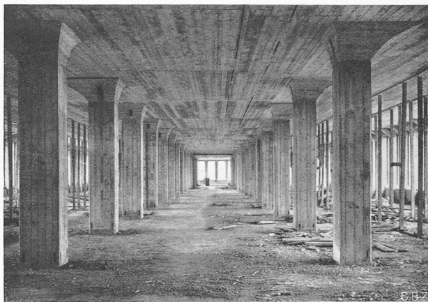
Abb. 47. Pilzdecke im 5. Obergeschoss.
