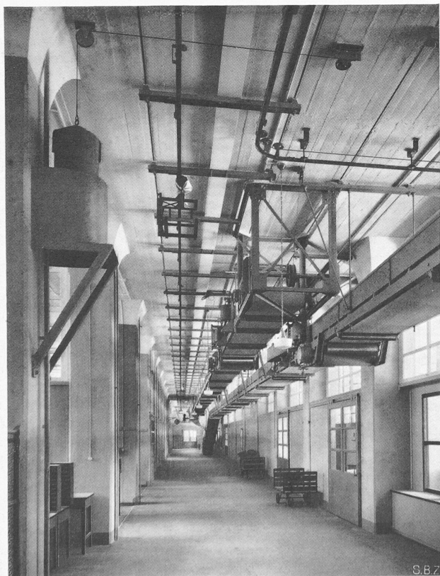
Abb. 28. Hängebahn und Förderbänder im Gang des Erdgeschosses
