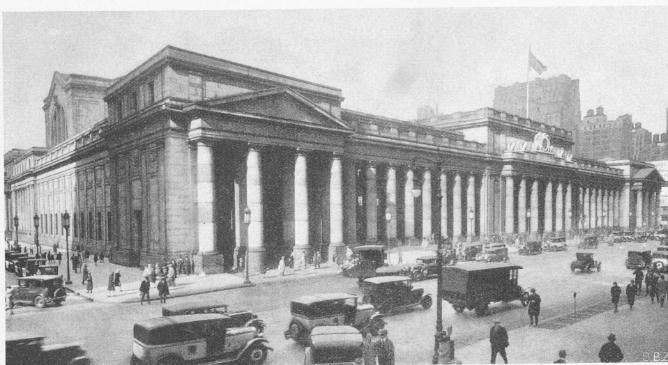
Abb. 13. Untergrund-Bahnhof der Pennsylvaniabahn in New York City.
