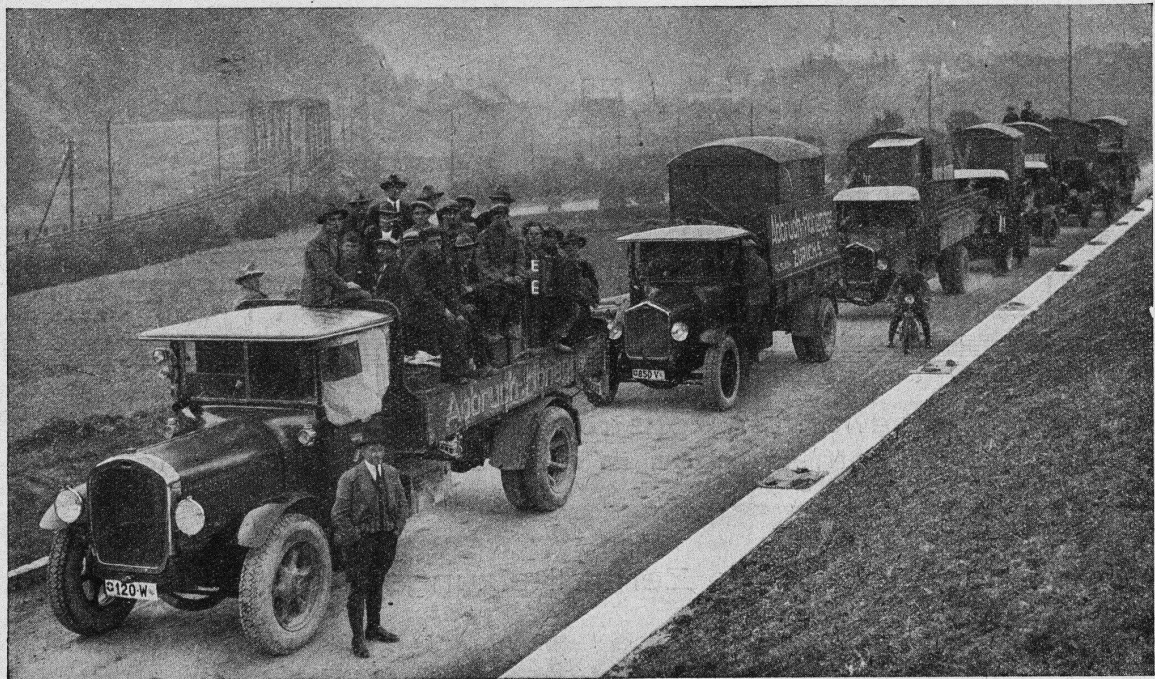
Sieben BERNÄ Kipper der aus zwölf BERNÄ bestehenden Kolonne für Abbrucharbeiten.
