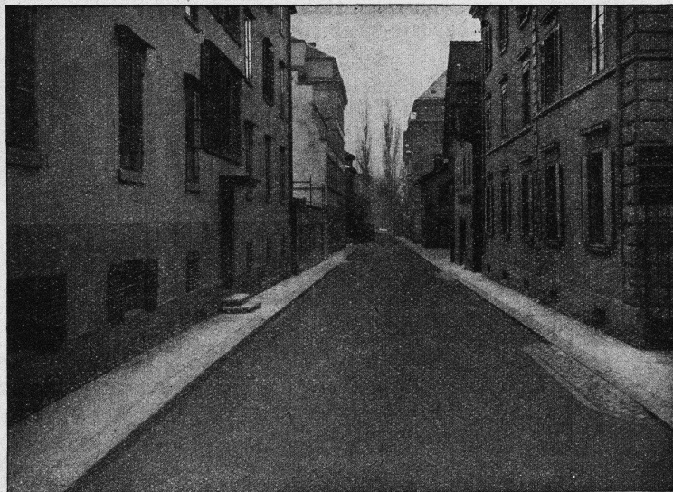
GLARNISCHSTRASSE ZÜRICH Walz-Asphalt: Topeka, 6 cm stark
