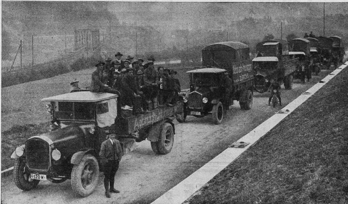
Sieben BERN A Klipper der aus zwölf BERN A bestehenden Kolonne für Abbrucharbeiten.
