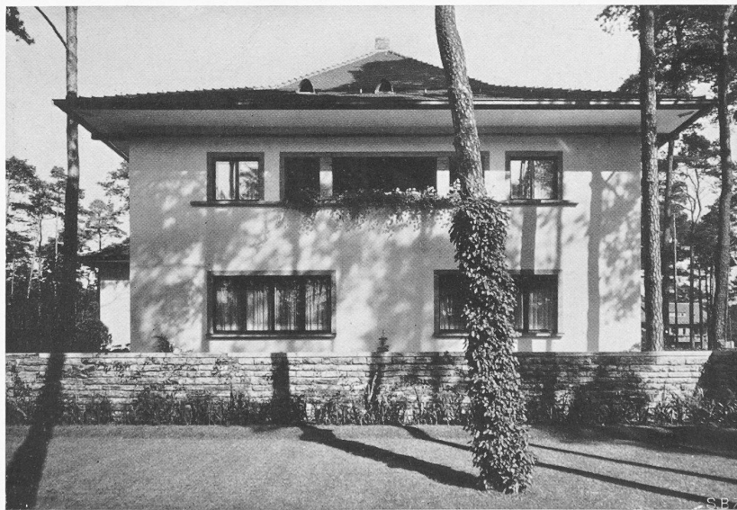
OBEN GESAMTBILD DER GARTENSEITE UNTEN STIRNANSICHT DES HAUPTFLÜGELS MIT LOGGIA DER TÖCHTERZIMMER IM OBERGESCHOSS HIERZU DIE GRUNDRISSE ABB. 6 UND 7 NEBENAN
