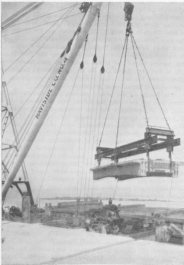
Abb. 51. Von der Montage der Strassenbrücke San Francisco-Mateo. Verlegen von 20 t schweren Brückentafeln mittels Schwimmkran.
